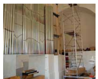
Orgelneubau in der Klosterkirche Vechta
