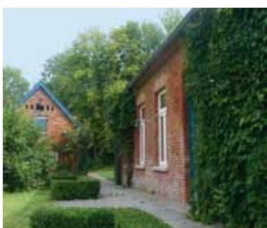
Gemeinderäume Atenser Diele in Nordenham-Atens
